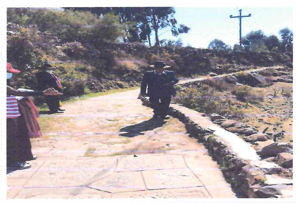
DIAGNÓSTICO SITUACIONAL DE LOS CAMINOS VECINALES
