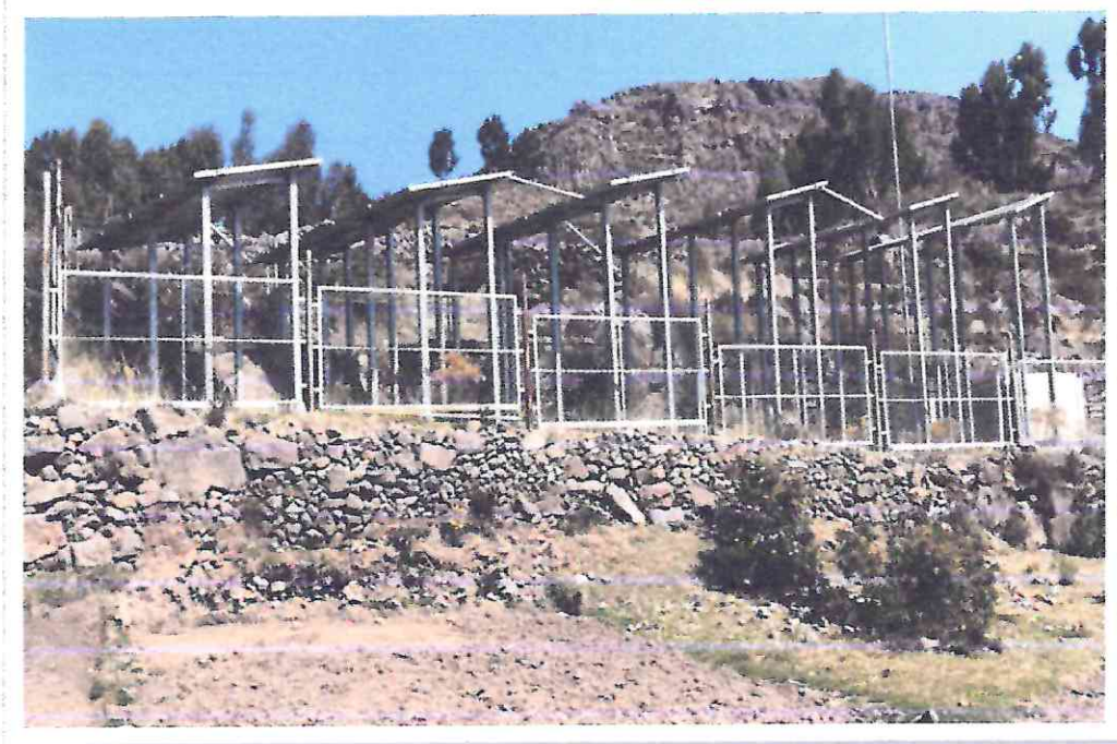
PANELES DE ENERGÍA SOLAR
